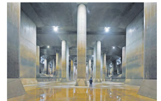
↑9 地下20mにつくられた首都圏の大雨時用の貯水施設(埼玉県春日部市、2018年撮影) 大雨で増水した河川の水を一時的に貯めることで、洪水による浸水被害を軽減する。
