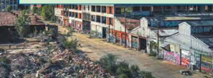
↑1 デトロイトの廃工場（ミシガン州、2018年4月撮影） 自動車の王国だったが、2013年に財政破綻した。現在は再建の途にある。
