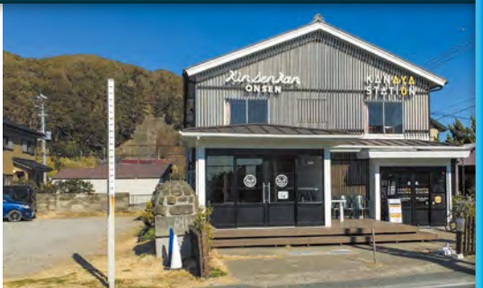
↑6 旅館跡を再生した観光案内・交流スペース (2020年2月撮影) 入浴・宿泊施設も併設され、多目的に使用できる。
